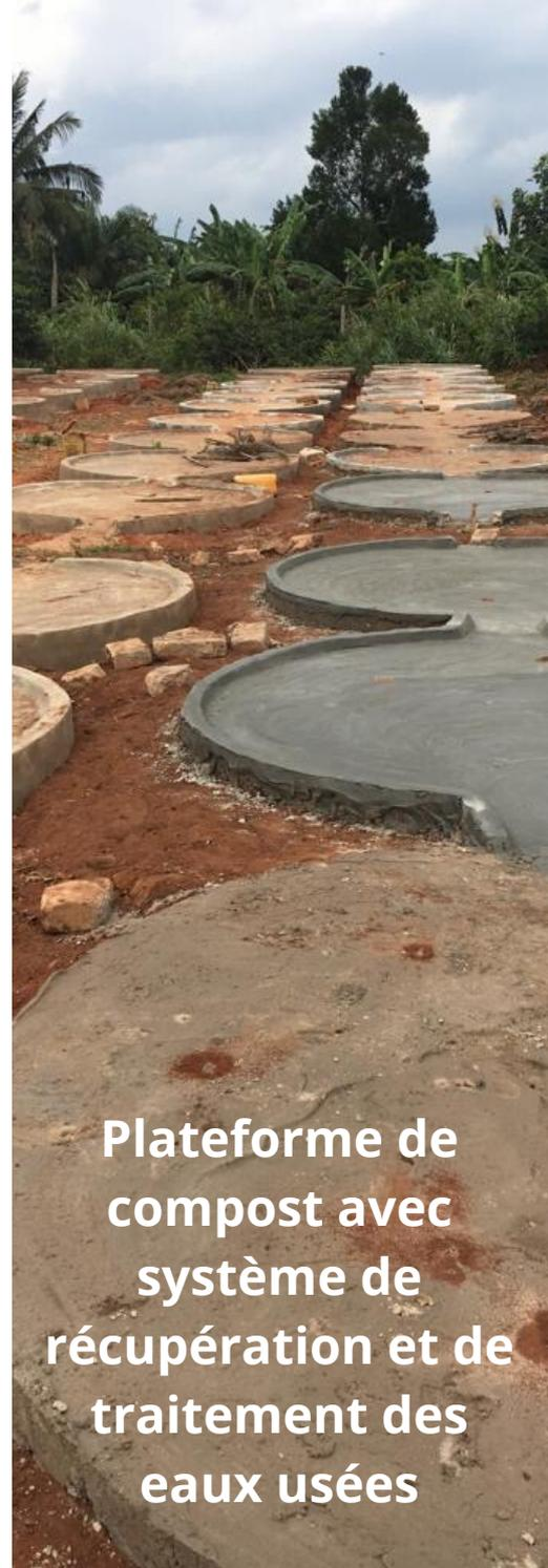
**Plateforme de compost avec système de récupération et de traitement des eaux usées**
